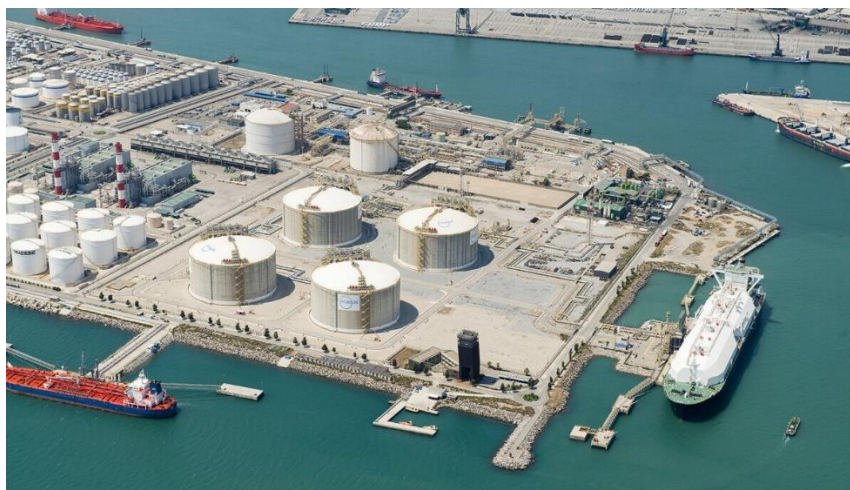
Ilustración 1. Planta de regasificación de Barcelona
